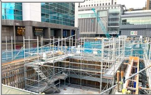
U型擁壁の型枠組立作業を行っています
