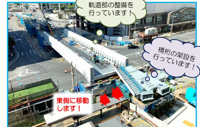
今後、大州通り北側(P4橋脚)と駅ビル間は路面電車が通行するため、橋桁を約半分架設した時点で東側に約6m横移動する作業を行います。
