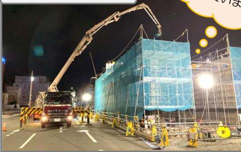
U型擁壁のコンクリート打設を行っています
