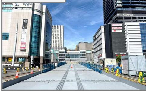
軌道桁の架設が完了し、軌道整備を進めています
