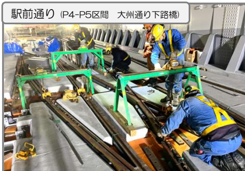
レール設置作業 施工中
