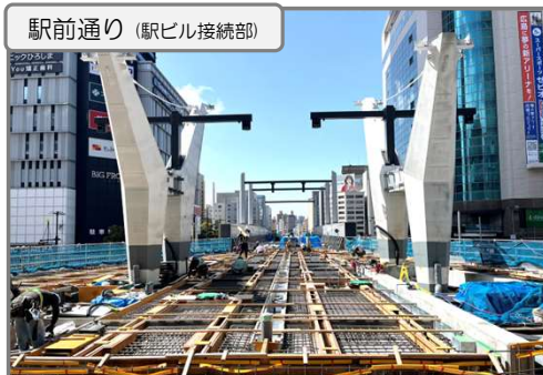
軌道スラブ 軌道設備 施工中
