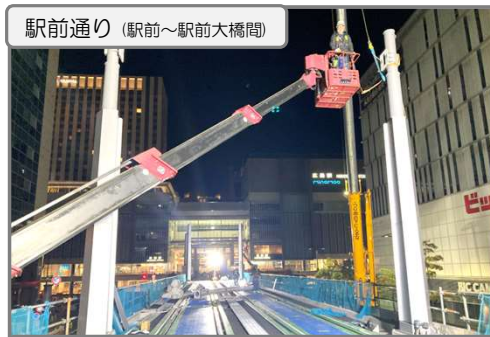
架線柱(門型)建て方 施工中
