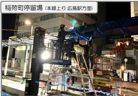
停留場上屋建て方 施工中
