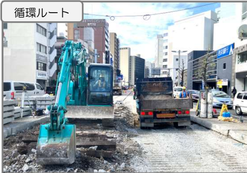
既設軌道設備を撤去中
