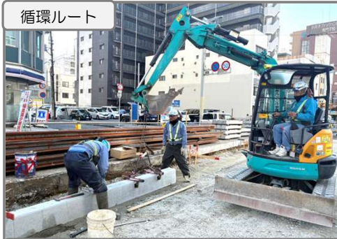
軌道設備を新設中
