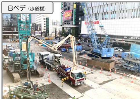
Bペデ 杭工事を施工中
