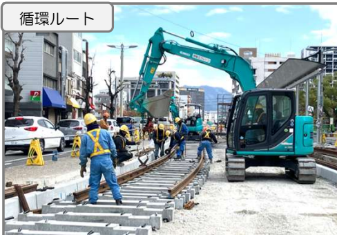
新設レール敷設中(的場～的場町1丁目交差点間)
