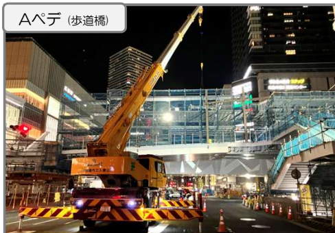
Aペデ 膜屋根を施工中
