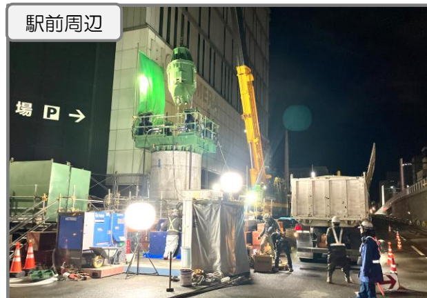
Bペデ PCウェル杭 施工中
