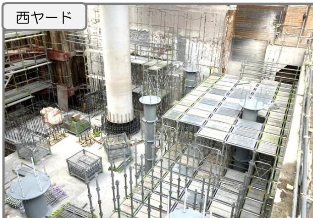
地下拡張部の上床版(天井) 施工中
