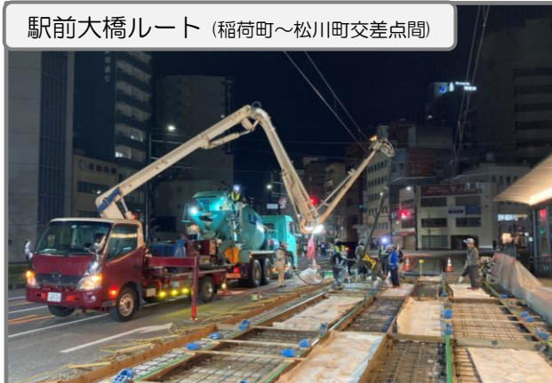
軌道部のコンクリート舗装施工中
