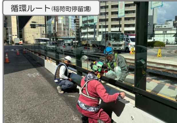
停留場 上屋付属物 施工中
