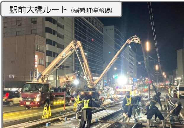
軌道部のコンクリート舗装 施工中
