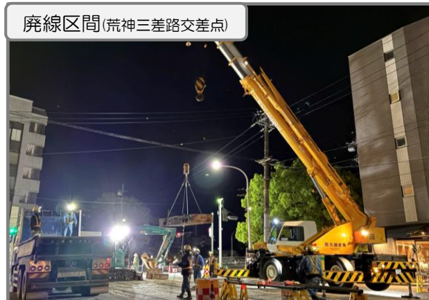
旧軌道部分撤去 施工中
