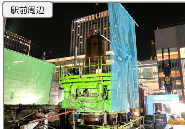
Bペデ 地下支障物撤去 施工中
