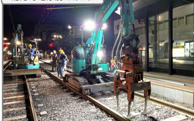
軌道整備 施工中
