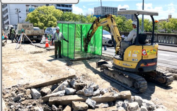
路面電車部分の補強工事 既設床版取壊し中
