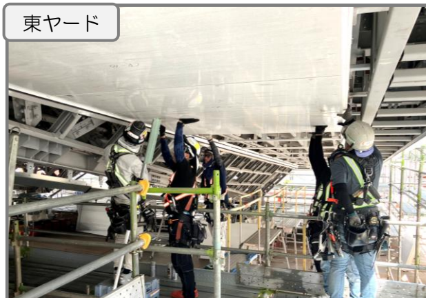
大屋根地組み(パネル設置) 施工中
