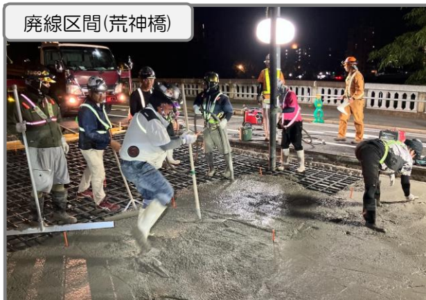
床版部 コンクリート打設 施工中
