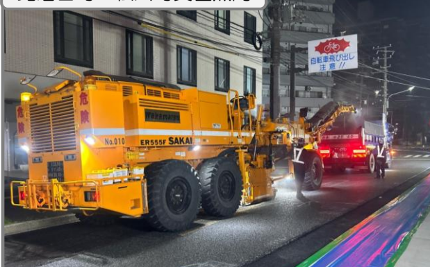
舗装の高さ調整を行っています(既設舗装の削り)
