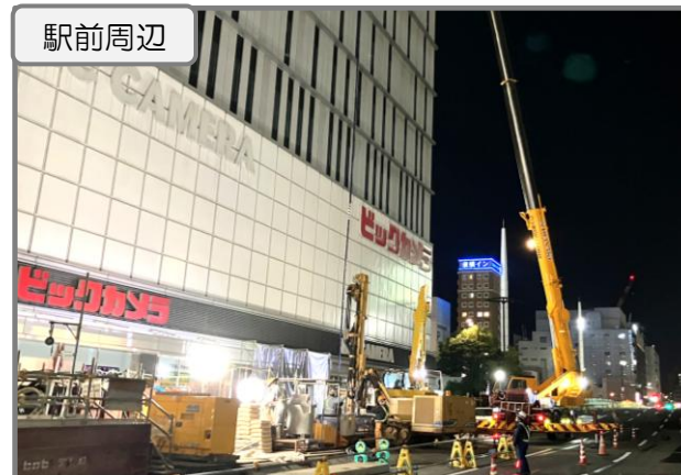
Bペデ 杭施工の準備作業中
