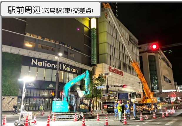
旧軌道部分 撤去中
