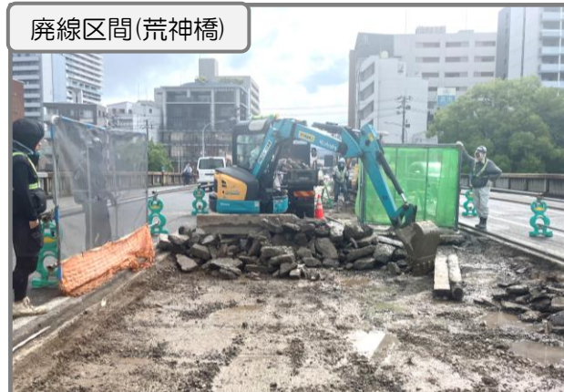
旧路面電車部分の補強工事 既設床版取壊し中
